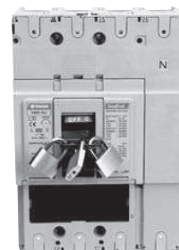
Автомат S400 заблокирован в положении OFF
