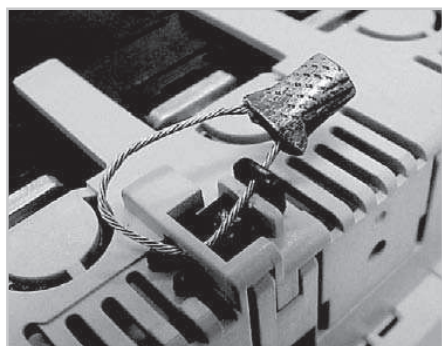
Блокировка клеммной крышки свинцовой пломбой
